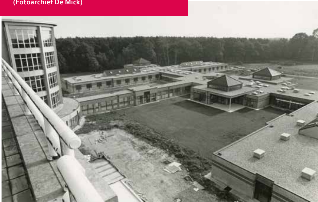
De Mick, het woonzorgcentrum in opbouw, 1994. (Fotoarchief De Mick)
